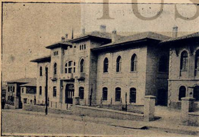
Divanı Muhasebat binası
